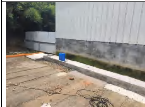
污水处理设施 (50m 3 /d)
