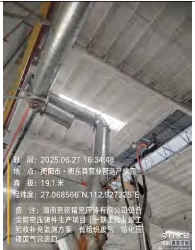
熔化压铸废气总进口（补充监测）
